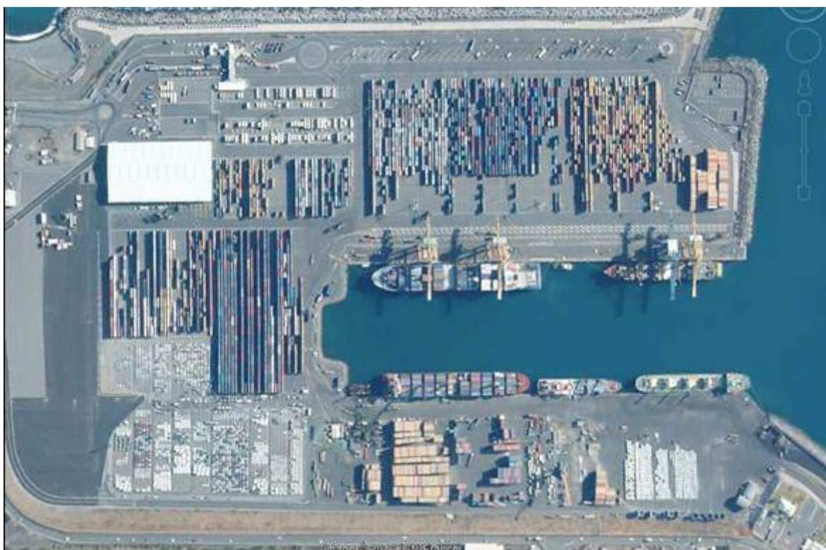
West Port, terminal de contentores
