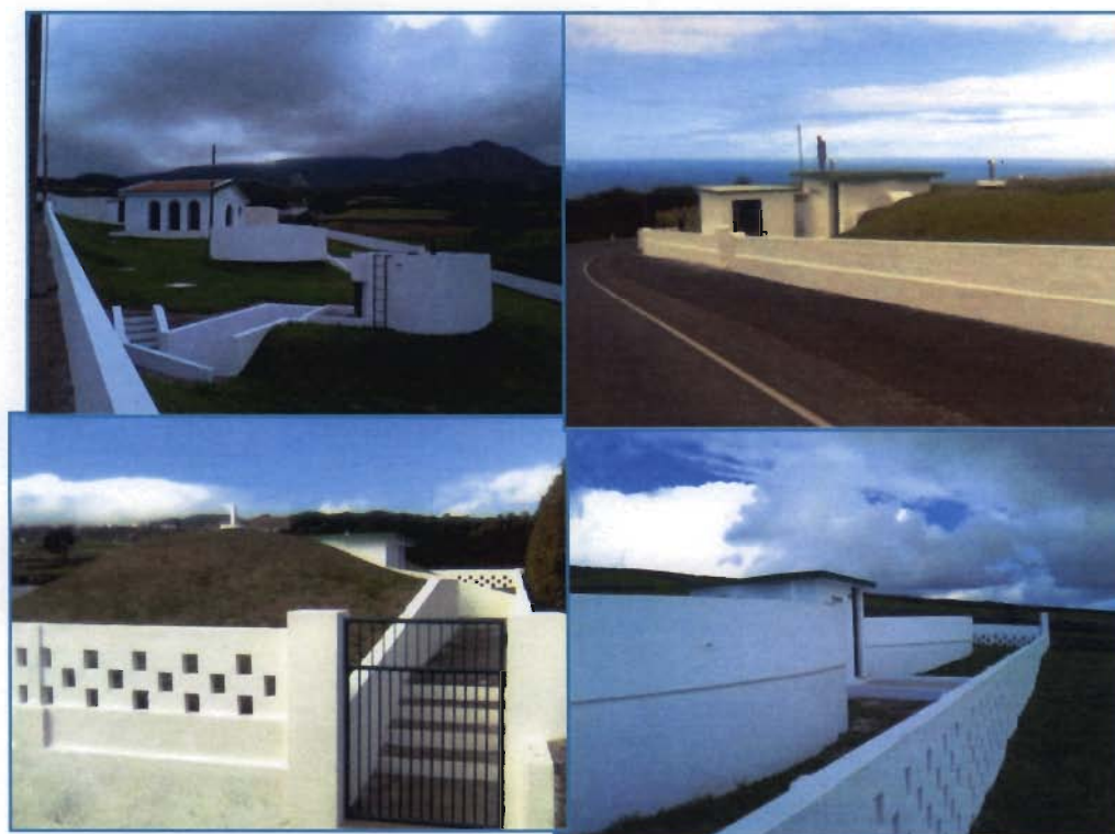
Figura 5 – exemplos de trabalhos de manutenção
