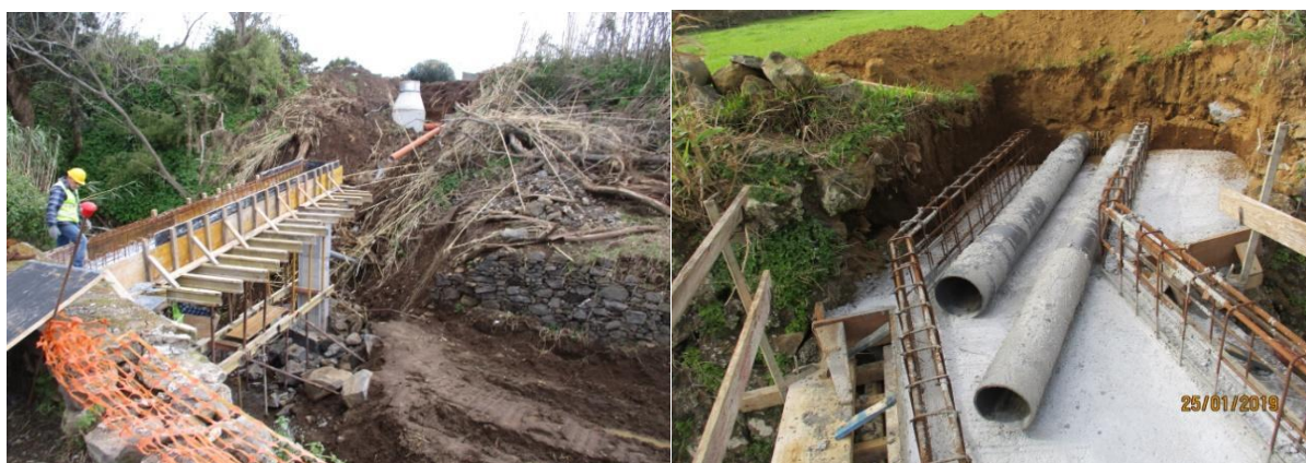
Figura 3 - Remodelação do Sistema de Drenagem Águas Residuais da Cidade de Angra do Heroísmo
