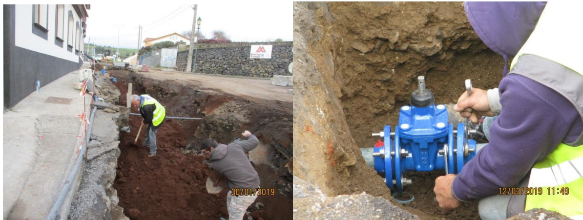
Figura 1 - Remodelação da rede de água e saneamento na Ladeira de São Bento
